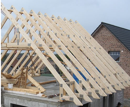
Dachstuhl aus statisch dimensionierter Holzkonstruktion.
