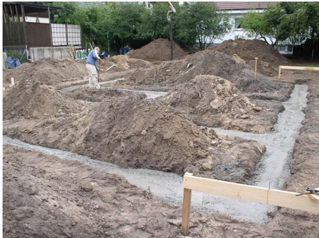
Technische Beispielaufnahme: Erdarbeiten und Fundamentvorbereitung.
