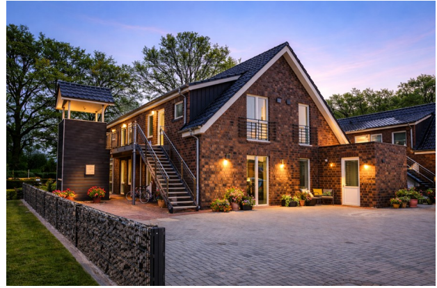
Referenzfassade mit gegliederten Fensterformaten.
