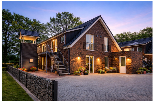
Wohnpark Apen: kompakte Gebäudeform als Teil des Energiekonzepts.
