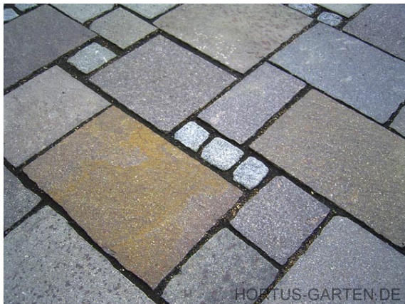
Beispiel für einen dauerhaft geeigneten Pflasterbelag.
