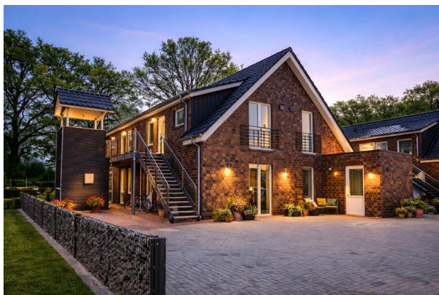
Referenz: realisierte Gebäudearchitektur im Wohnpark Apen.
