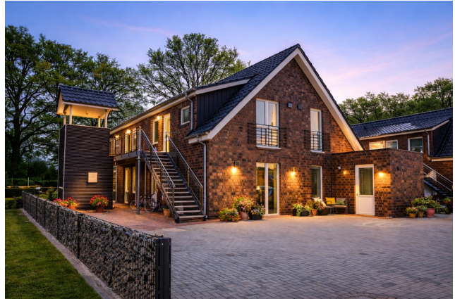
Referenzarchitektur: Klinkerfassade und klar gegliederte Baukörper.
