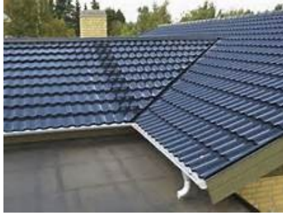
Dunkle Dachdeckung mit erforderlichen Formteilen.
