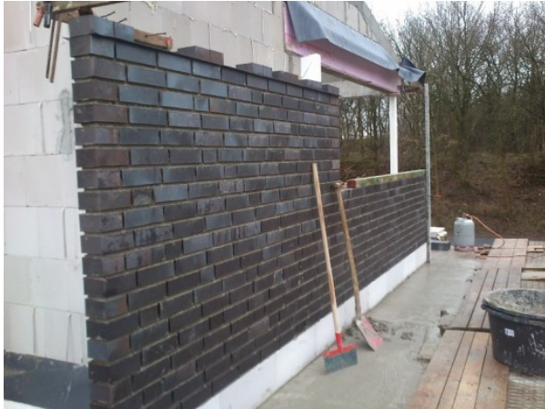
Technische Beispielaufnahme: zweischaliges Mauerwerk mit Verblendfassade.
