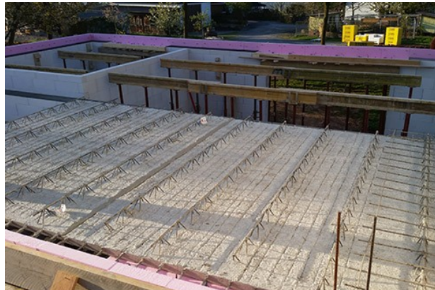
Technische Beispielaufnahme: Stahlbeton-Elementdecke im Rohbau.
